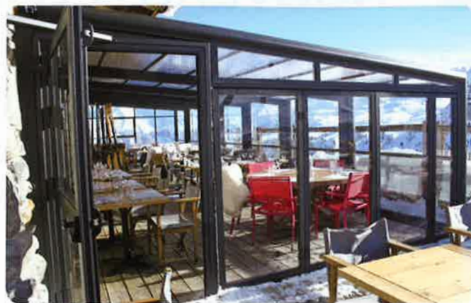
Abri de terrasse Sôkôol
